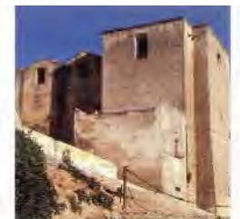
FACCIATA SECONDARIA E CAMPANILE DELLA CHIESA MADRE (1776-1830). CHIESA DEL CROCIFISSO (SEC. XVII).
